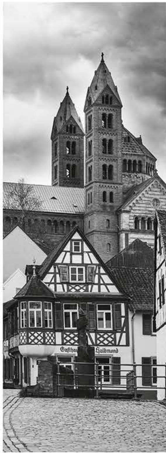
11. BLICK VON SONNENBRÜCKE AUF NORDWESTSEITE DES DOMS
